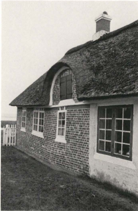
Nordsiden af Digevej 31
