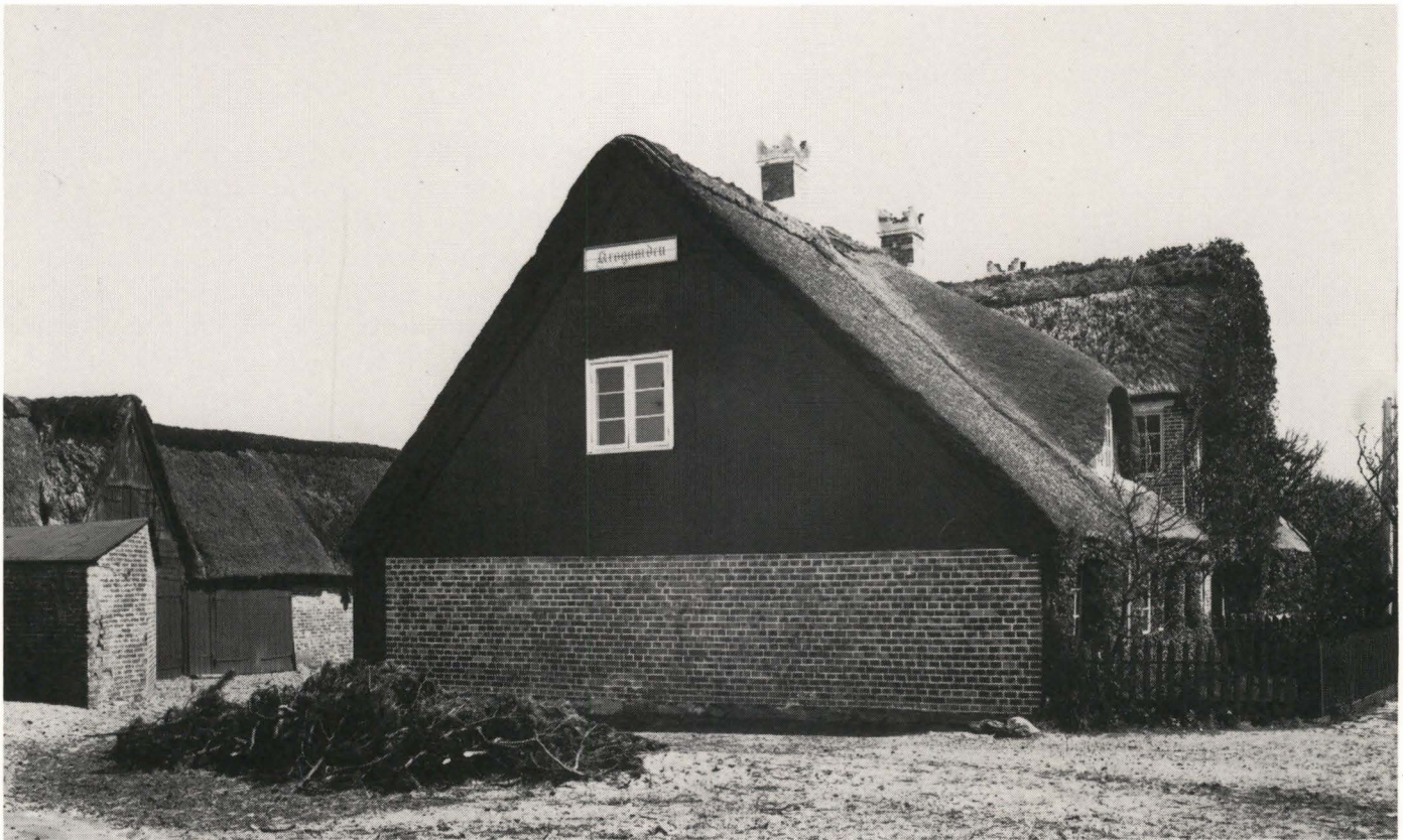
Bræddebeklædt gavltrekant på Kroen. HM fot. 1928.
