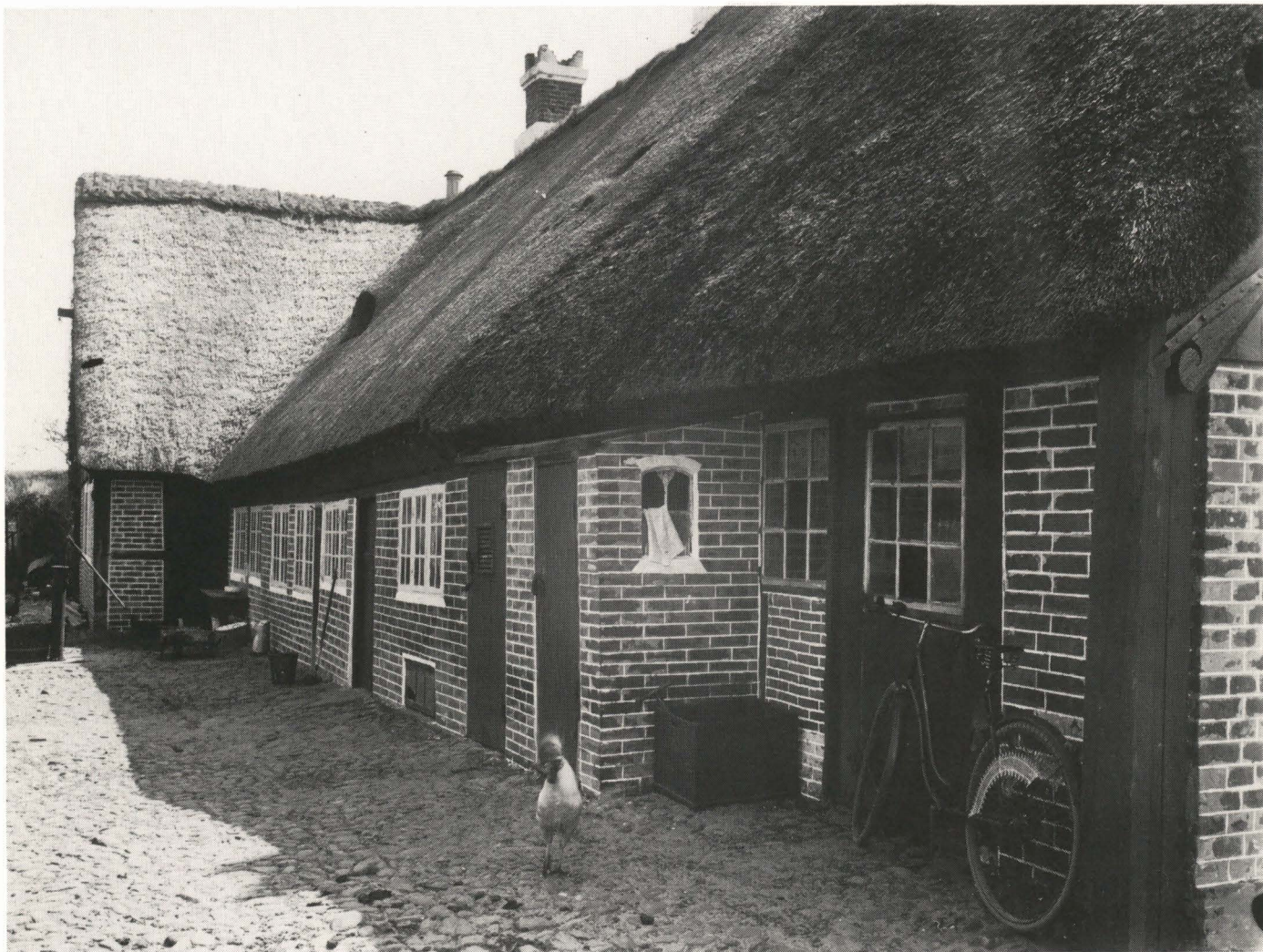
Bindingsværksfragmenter i Kroens nordside. HM fot. 1928.
